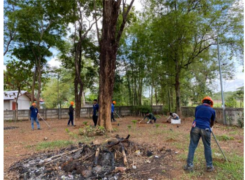
โรงงานไทยรุ่งเรืองอุตสาหกรรม (จ.สกลนคร) ปรับปรุงภูมิทัศน์ภายในวัดบ้านหนองบัวสร้าง ต.อุ่มจาน อ.กุสุมาลย์ จ.สกลนคร
